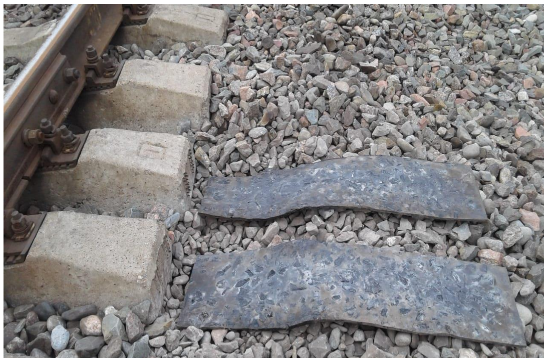
Рисунок 2.10. Фотография изъятых подшпальных прокладок.
